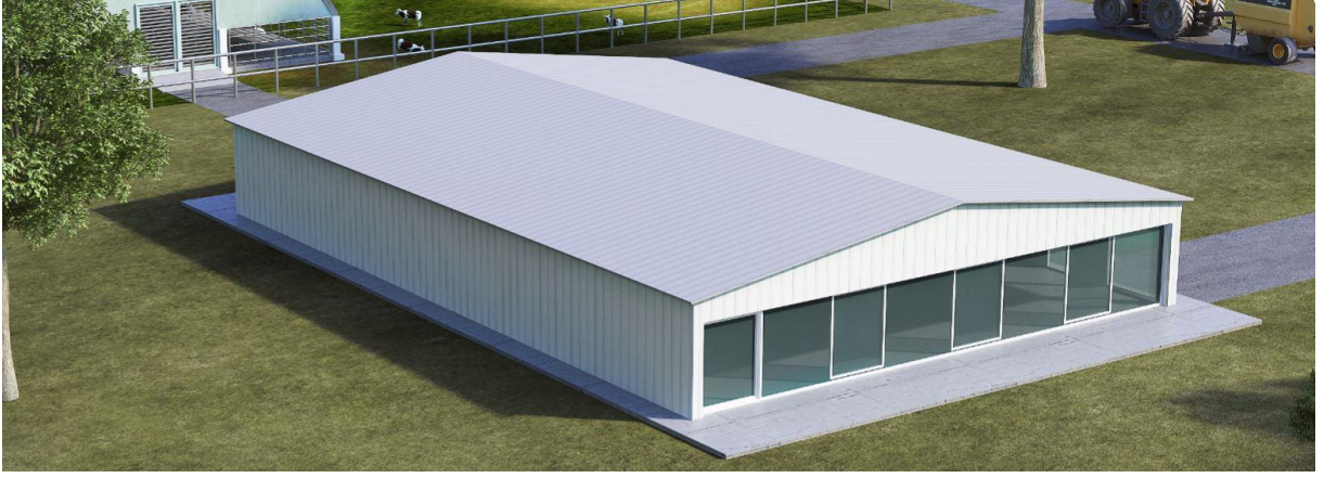
Resim 11 : Kaba ve Kesif Yem Deposu ( Saç Panel)
